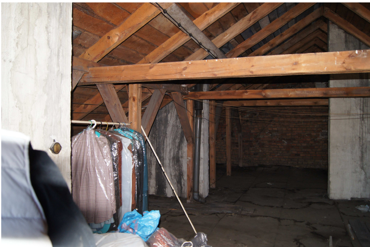
Wnętrze poddasza- widok więźby dachowej
