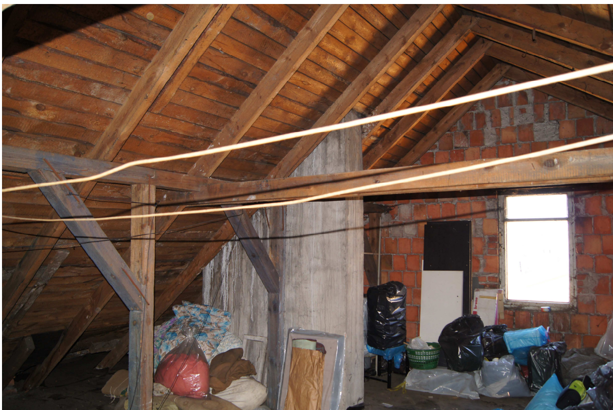
Wnętrze poddasza- widok więźby dachowej
