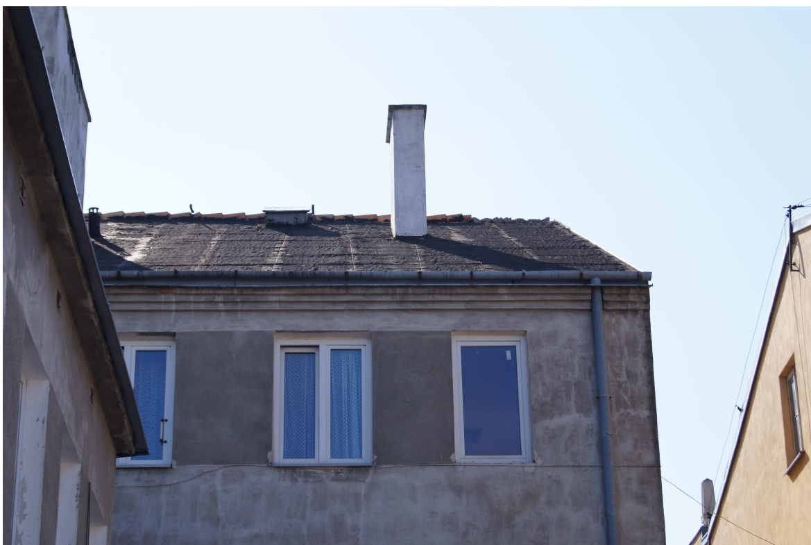
Widok dachu od strony wnętrza dziedzińca
